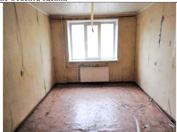
Фото 6. Внутреннее состояние Объекта оценки
